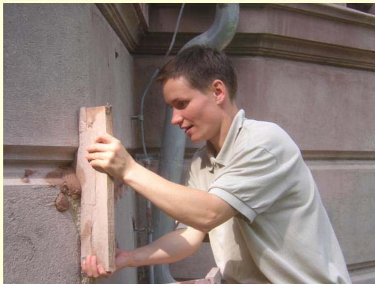
Stukkateurarbeiten – Rost Stukkateur GmbH
